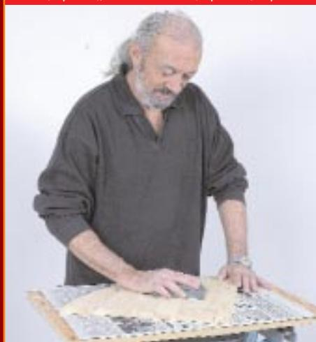
2 С помощью шпателя покрываем плоскость слоем алкидной шпатлевки
